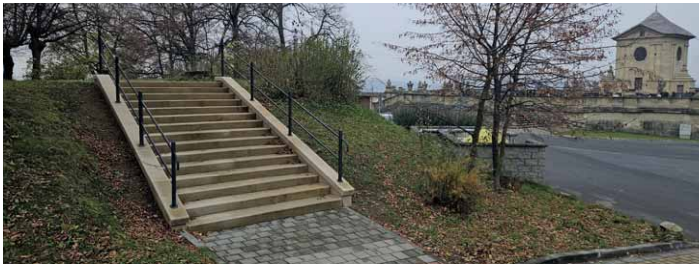
Nové schody za kostelem
